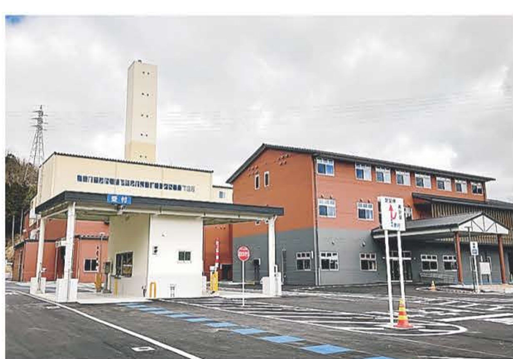
西脇多可新ごみ処理施設建設工事
