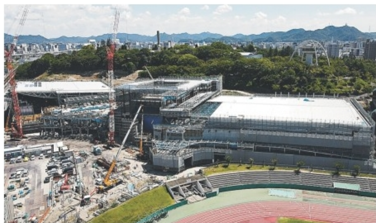
建設中のひめじスーパーアリーナ＝9月2日、姫路市西延末（ドローンで撮影）
